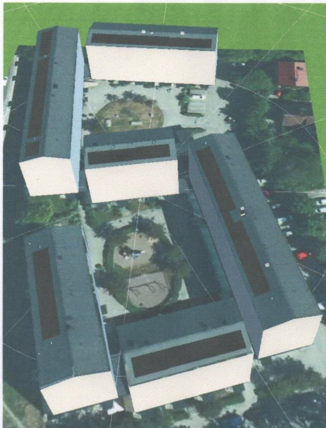
Översiktsbild över samtliga solcellsanläggningar
